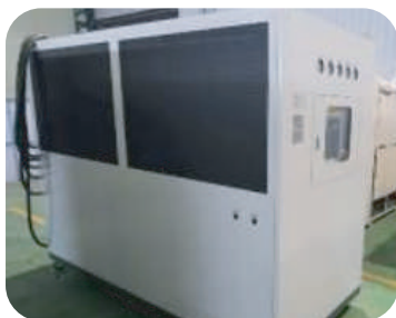
伺服節能冷水機 (2024.9.1安裝完成)
